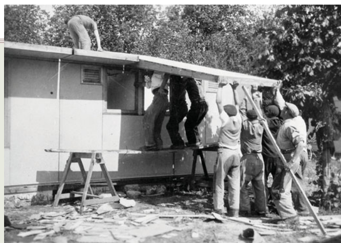
Des hommes participent au montage d'un bungalow américain type UK 100 pendant la Reconstruction
