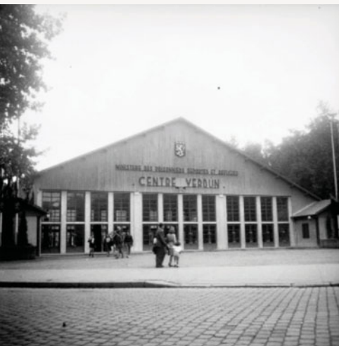
Installation provisoire du ministère des Prisonniers, Déportés et Réfugiés, cours de Verdun, Lyon, 1945
